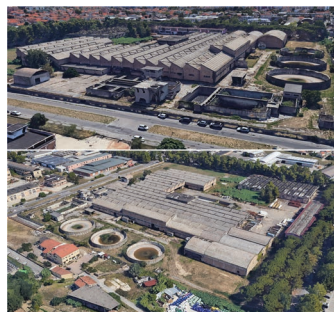
PROSPETTIVA DEL COMPLESSO DELLA CONCIERIA DI PELLAMI EX-COGOLO DAL LATO SUD E OVEST NELLE CONDIZIONI ATTUALI; IMMAGINE REALIZZATA SU GOOGLE EARTH.
