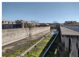
COMPLESSO EX-COGOLO, VASCA PER LA CONCIA ALLO STATO ATTUALE.
